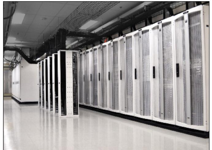
TCS construyó un centro de datos de exhibición que ganó dos premios ASHRAE y un *PUE* regular del 1,15 usando 50 gabinetes TeraFrame Serie F con Ductos de Escape vertical, Administración de cables *Evolution* y Sistemas de Bastidores CPI.
