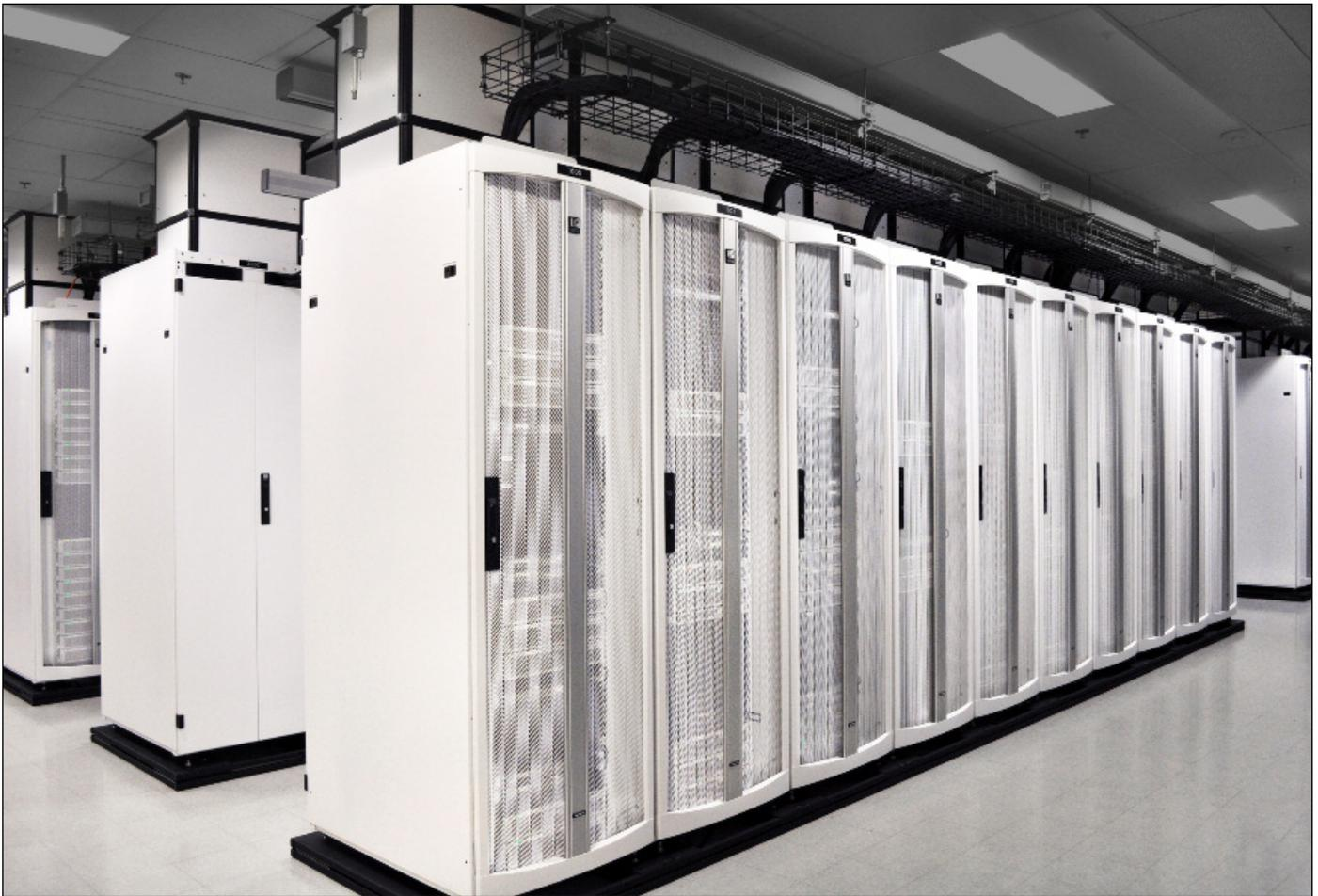
Al contener el aire y dirigirlo al techo a través de un Ducto de Escape Vertical, los gabinetes TeraFrame Serie F de CPI ayudaron a TCS a expandir su centro de datos con una estrategia de refrigeración que eliminó la refrigeración mecánica y redujo en gran medida el consumo de energía.
