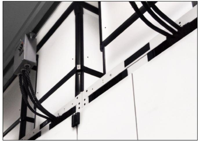
Una de las formas en las que TCS ha sido capaz de optimizar su sistema de refrigeración fue manteniendo el aire caliente contenido en el gabinete y separado de la sala mediante una combinación de Ductos de Escape Vertical y arandelas cerradas por cepillos con diseño personalizado.
