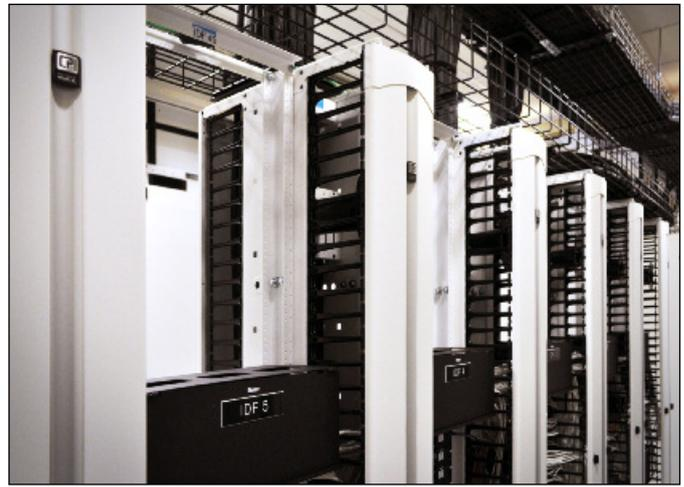
Los Sistemas de Bastidores CPI y la Administración de Cables *Evolution*, ambos de color blanco glaciar, se usaron para aumentar la capacidad de cableado y reducir los costos de iluminación en la expansión del centro de datos de TCS.
