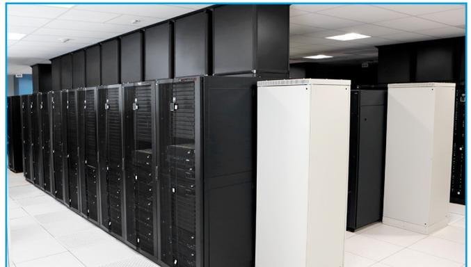
机柜解决方案包括 CPI 带有垂直排风管的 GF 系列 GlobalFrame® Gen 2 机柜、监控式 eConnect® 配电装置和多种线缆管理配件。
