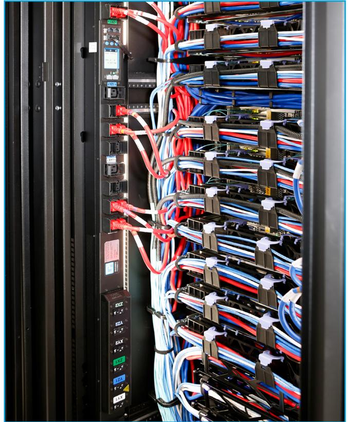
CPI 的监控式 eConnect® 配电装置可支持两个温度和湿度探头，为每个机柜提供温度和湿度测量；同时配备 Secure Array® IP 合并技术，极大地减少所需的网络端口数量。
