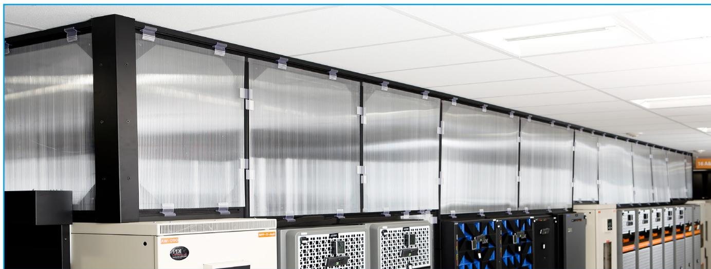
就通道层面的气流封闭而言，CPI 按规范制造组件 (BTS) 热通道封闭 (HAC) 的灵活性和现场定制功能，能将现有多供应商机柜所产生的热废气包容在内。
