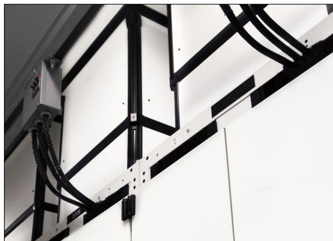
TCS优化其冷却系统的方法之一是通过将热空气遏制在机柜内，并通过垂直排风管和定制设计的刷式密封垫环的组合使热空气与机房隔绝。
