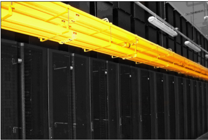
Vivo 数据中心现在拥有 191 台配有垂直排风管的 GlobalFrame 机柜并帮助公司获得了 Tier III 的设施等级。(使用本图像演示 VED。)
