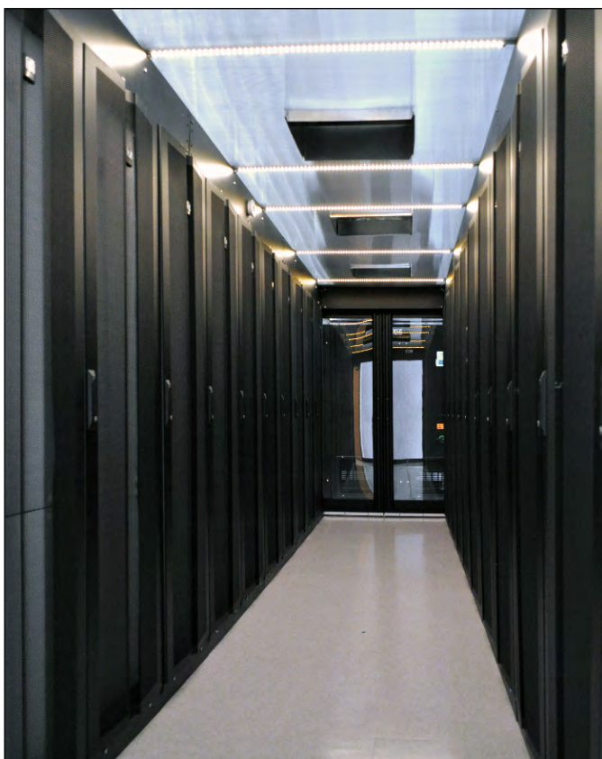
Para Hostirian , la construcción de la CAC fue económica, ya que cuentan con un piso de losa y no tiene cámaras de distribución.
