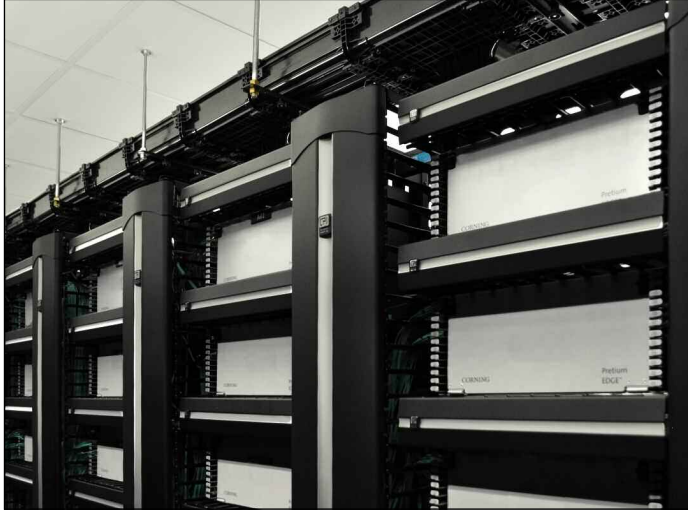
Los Bastidores Estándar de dos Postes de CPI y la Administración de Cables Evolution administran la interconexión cruzada de fibra de Scripps Networks.
