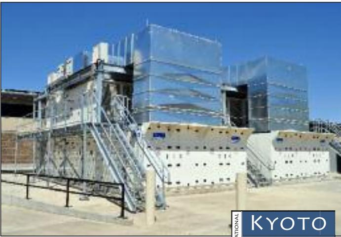
Vault 安装有北美最大 KyotoCooling® 热交换轮中的两个，与 CPI 机柜相结合，它们可实现零费用冷却以及使 PUE 低至 1.2。
