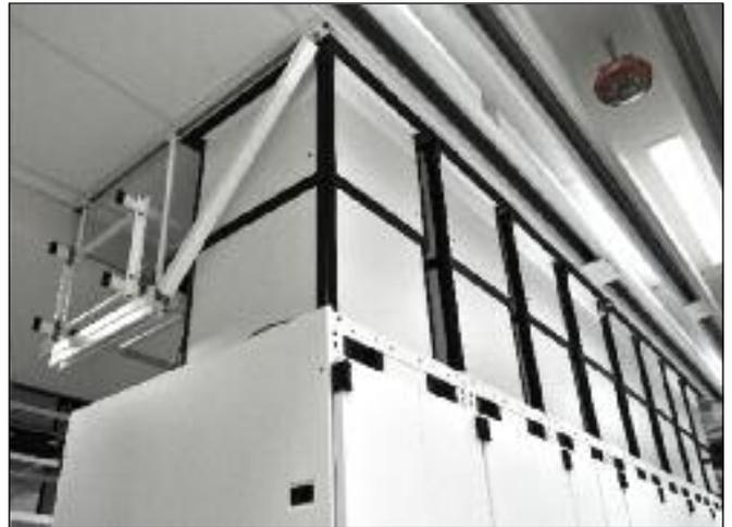
垂直排风管将加热回风输送至增压空间，由其对热空气与冷空气进行隔离，从而成为一款可提高 KyotoCooling® 与传统冷却系统效率的防护装置解决方案。
