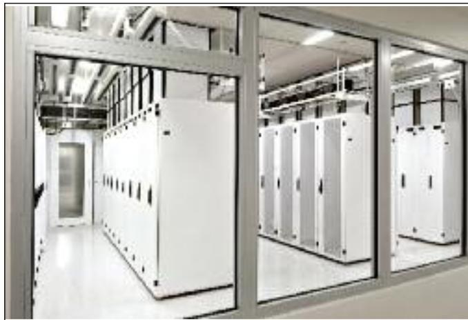
为了打造俄勒冈州最环保的托管设施，BendBroadband Vault 采用了 CPI Passive Cooling® 并通过安装带有垂直排风管的 F 系列 TeraFrame® 机柜系统进行隔热。
