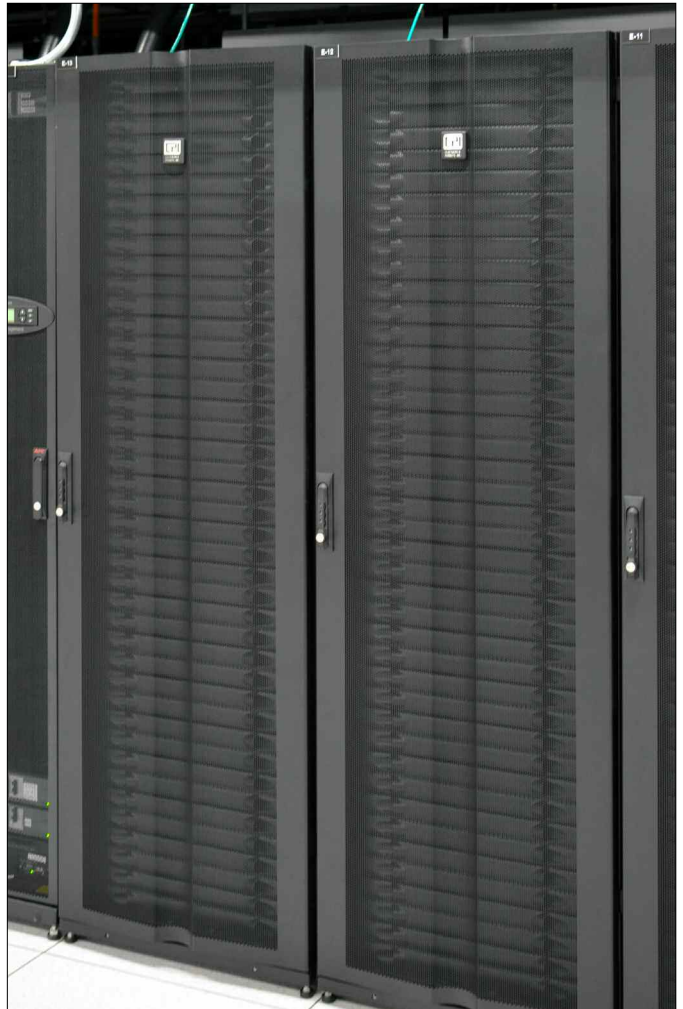
为改善 Cologix 达拉斯数据中心气流效率，安装了 CPI 的 GF 系列 GlobalFrame 机柜，其包含定制门、支撑挡板和 HotLok® 快速拆卸式盲板。
