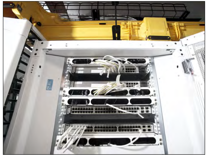
专为需要侧向气流的交换机设计的 CPI 定制风箱
