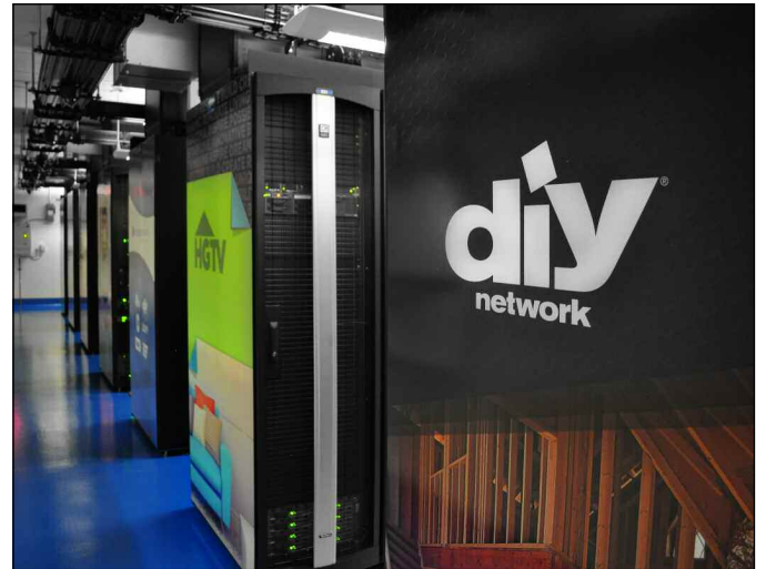
CPI 的双立柱标准机架和 Evolution 缆线管理可管理 Scripps Networks 的光纤交叉连接处。
