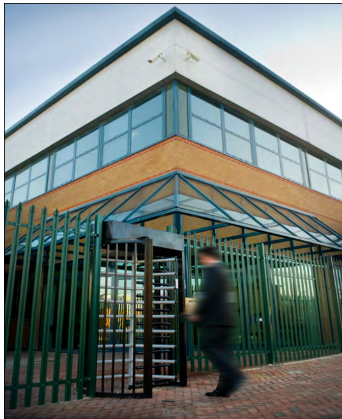
Powergate, TelecityGroup 的第八个伦敦数据中心，处于数据中心的创新前沿位置，给托管设施提供每个机柜高达 20kW 的功率。
