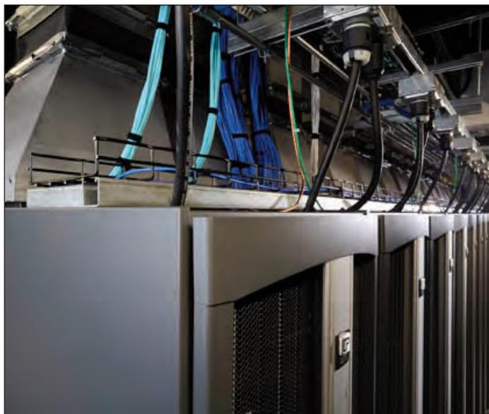
CDW 已在其新建数据中心机构的一期工程中安装了 103 台配有垂直排风管管的 F 系列 TeraFrame 机柜。
